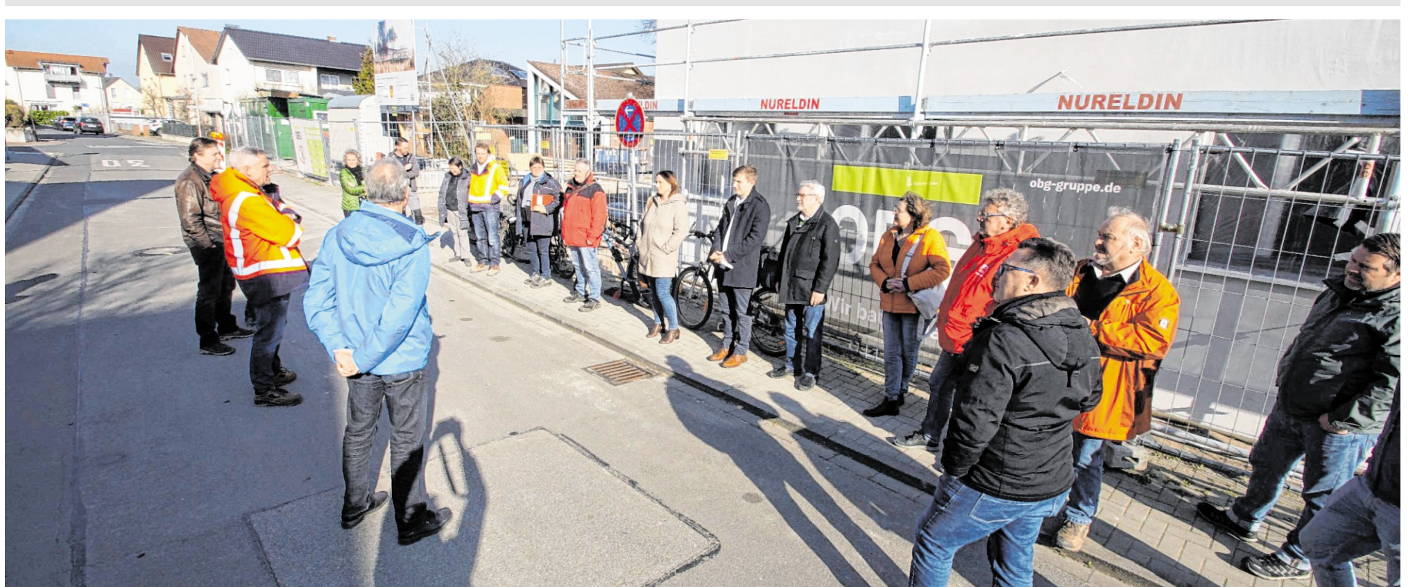
Einhäuser Gemeindevertreter informierten sich bei einem Ortstermin über die Fortschritte in den neuen Kindergärten. Unser Bild zeigt die Runde an der Baustelle der evangelischen Kita. BILD: ZELINGER
